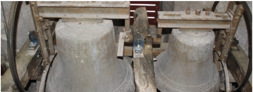
Vorher: rechte Glocke mit abgesprungener Antriebskette
